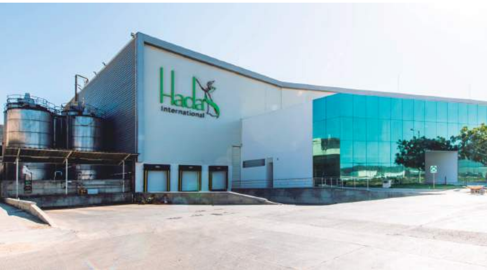
BODEGA ZONA FRANCA LA CAYENA -Juan Mina
