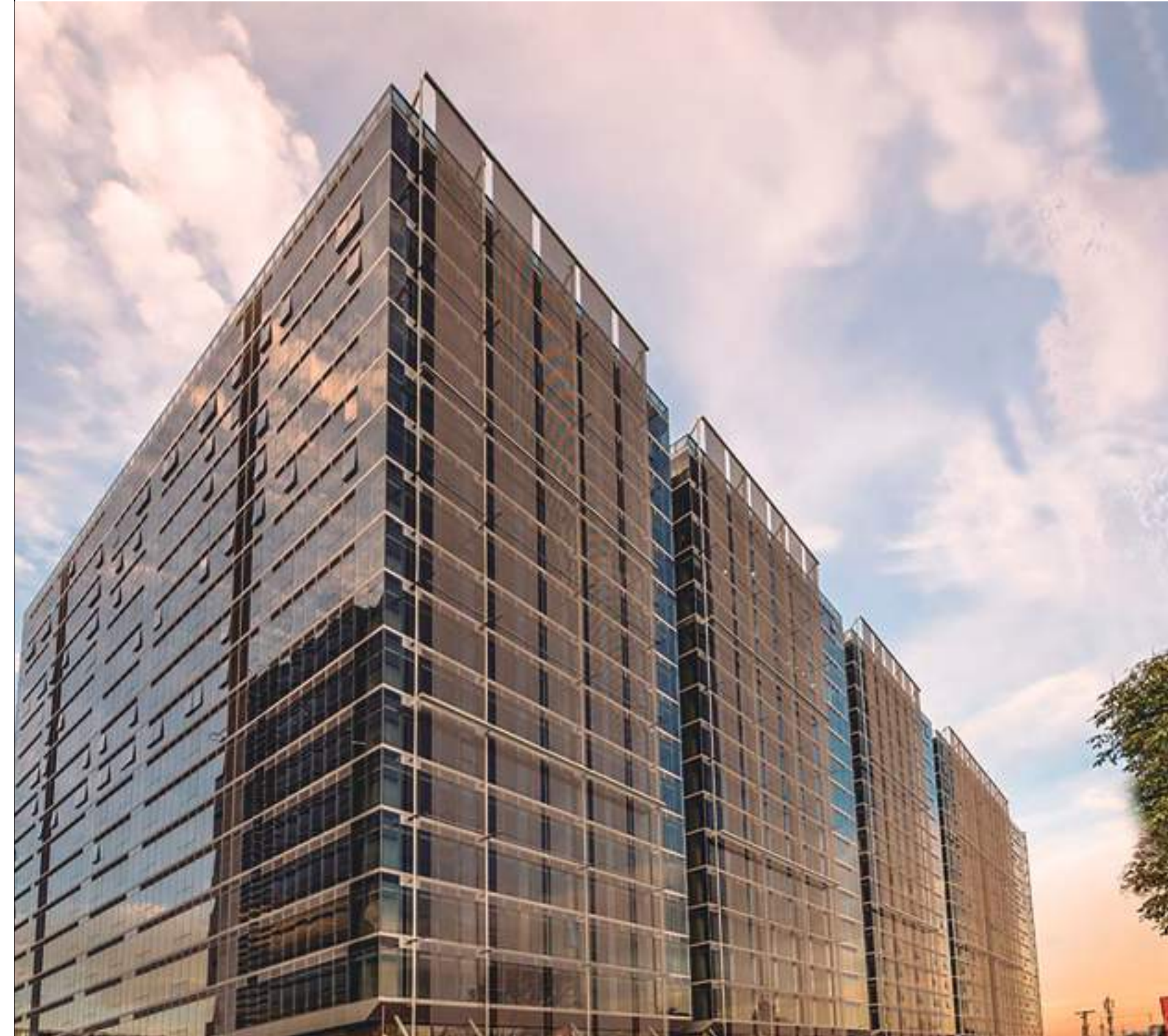
TORRE ELEMENTO -Bogotá
