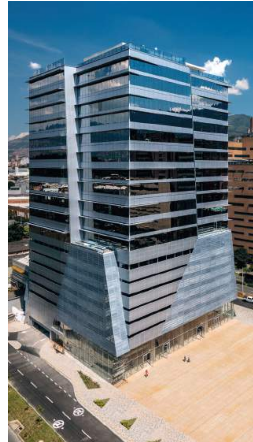
EDIFICIO RIVANA BUSINESS -Medellín
