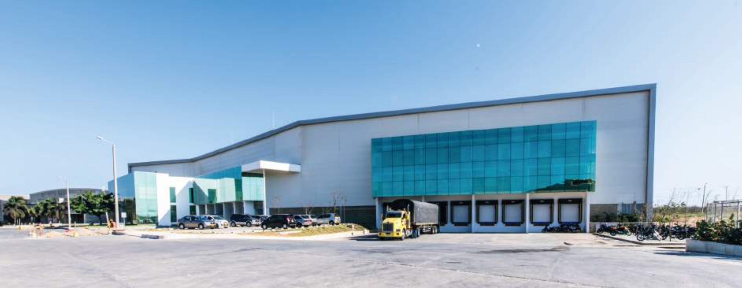
BODEGA ZONA FRANCA LA CAYENA -Juan Mina
