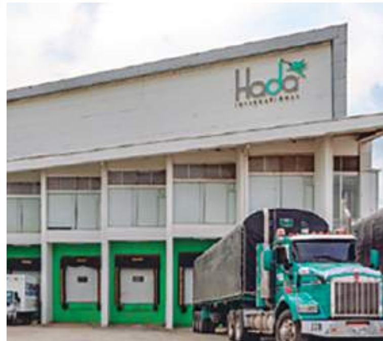
BODEGA ZONA FRANCA LA CAYENA -Juan Mina
