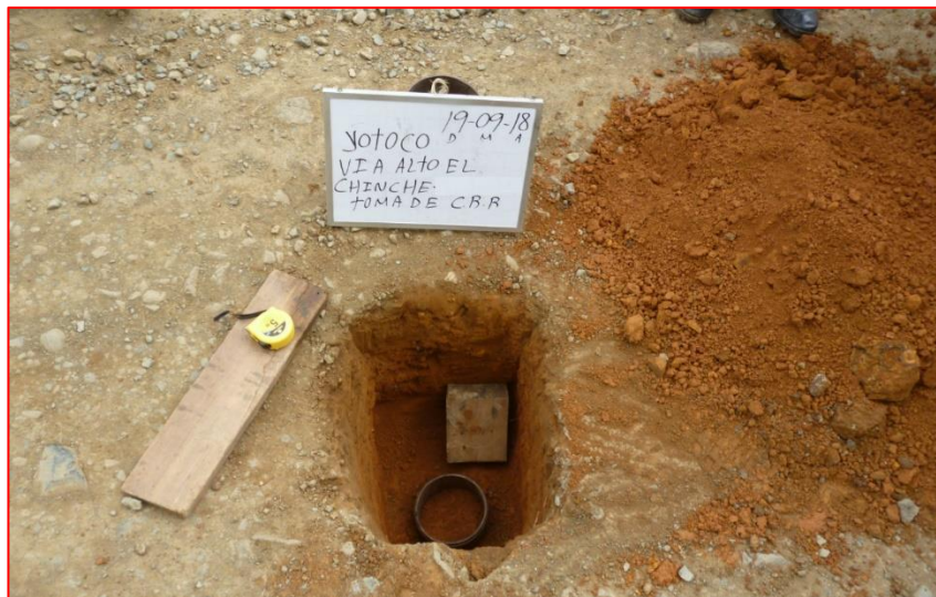
Foto No. 9 Toma de CBR Inalterado.
