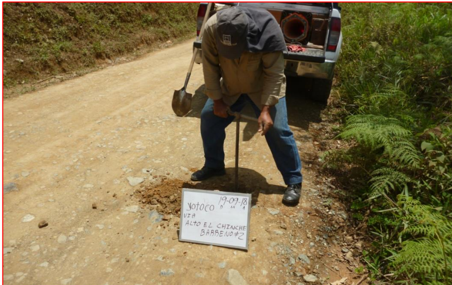
Foto No. 7 Capa de rodadura de poco espesor y limo arcilloso
