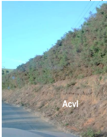
Foto 10 Corte vertical de ladera (Acvl)
