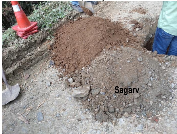
Foto 3 Material de recebo usado para mejoramiento de los tramos de vía
