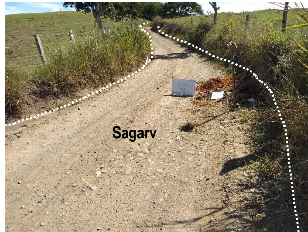
Foto 3 Material de recebo usado para mejoramiento de los tramos de vía
